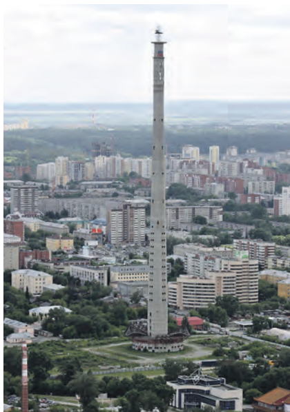
Der Fernsehturm im Zentrum Jekaterinburgs wurde am 24. März 2018 gesprengt, obwohl sich Einwohner der Stadt für die Erhaltung des Wahrzeichens eingesetzt hatten.
