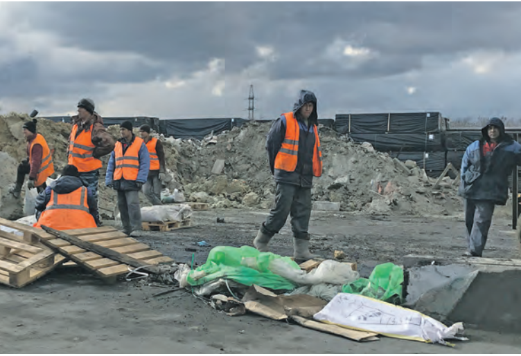
Zentralasiatische Arbeiter auf Moskauer Baustellen arbeiten oft unter widrigen Bedingungen.
